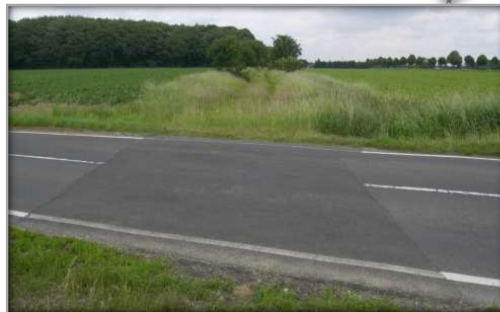
Rückgebaute Bahnstrecke in Schwalmtal
