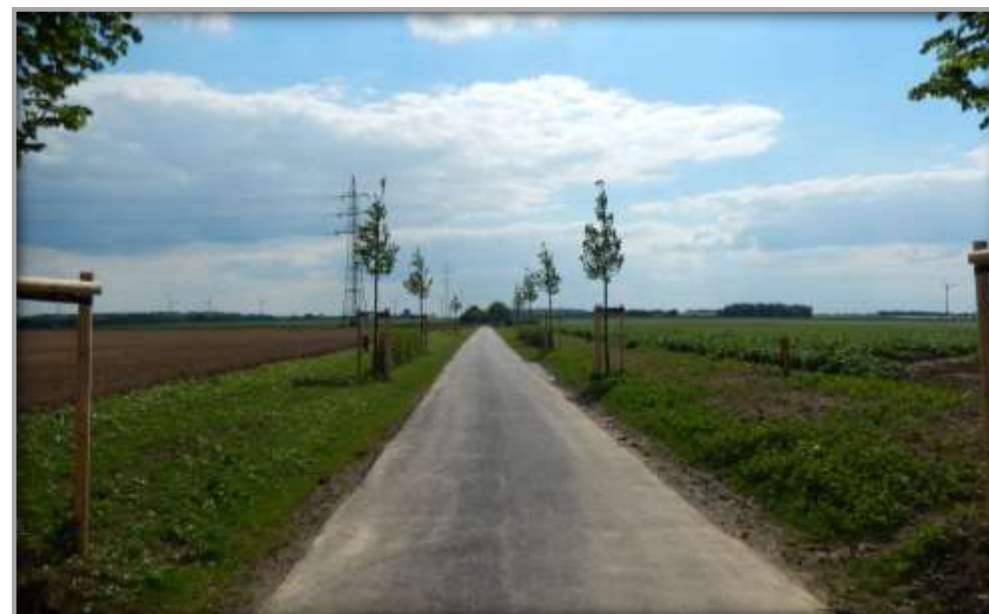
Fertiggestellter Alleenradweg in Schwalmtal
