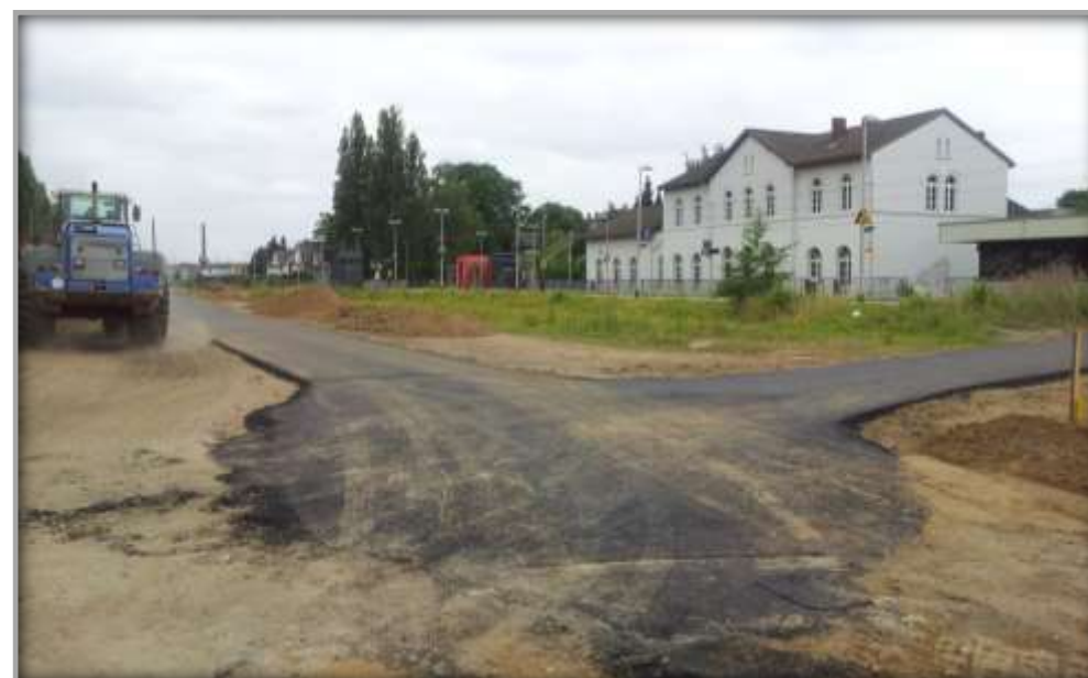
Alleenradweg am Bahnhof Viersen im Bau
